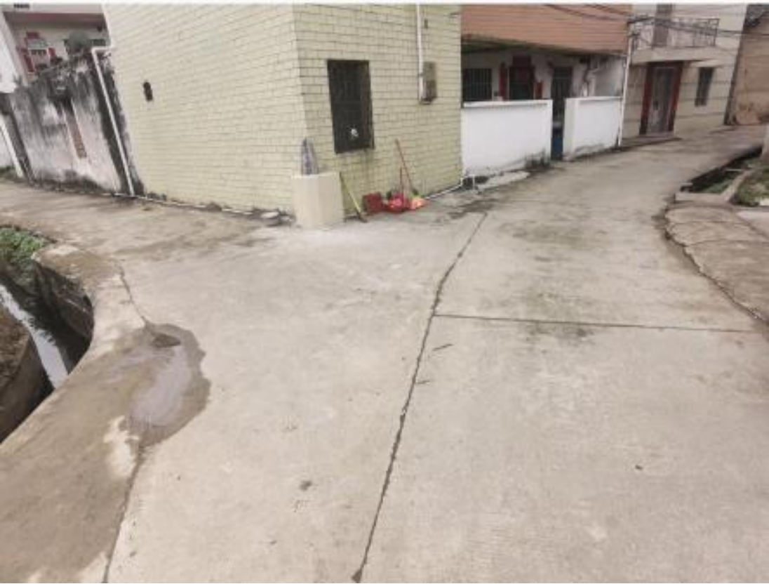
现场图片1 起点
