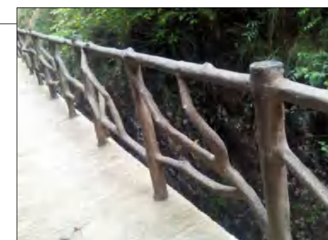
8 仿木栏杆意向图 SCALE 1:20
