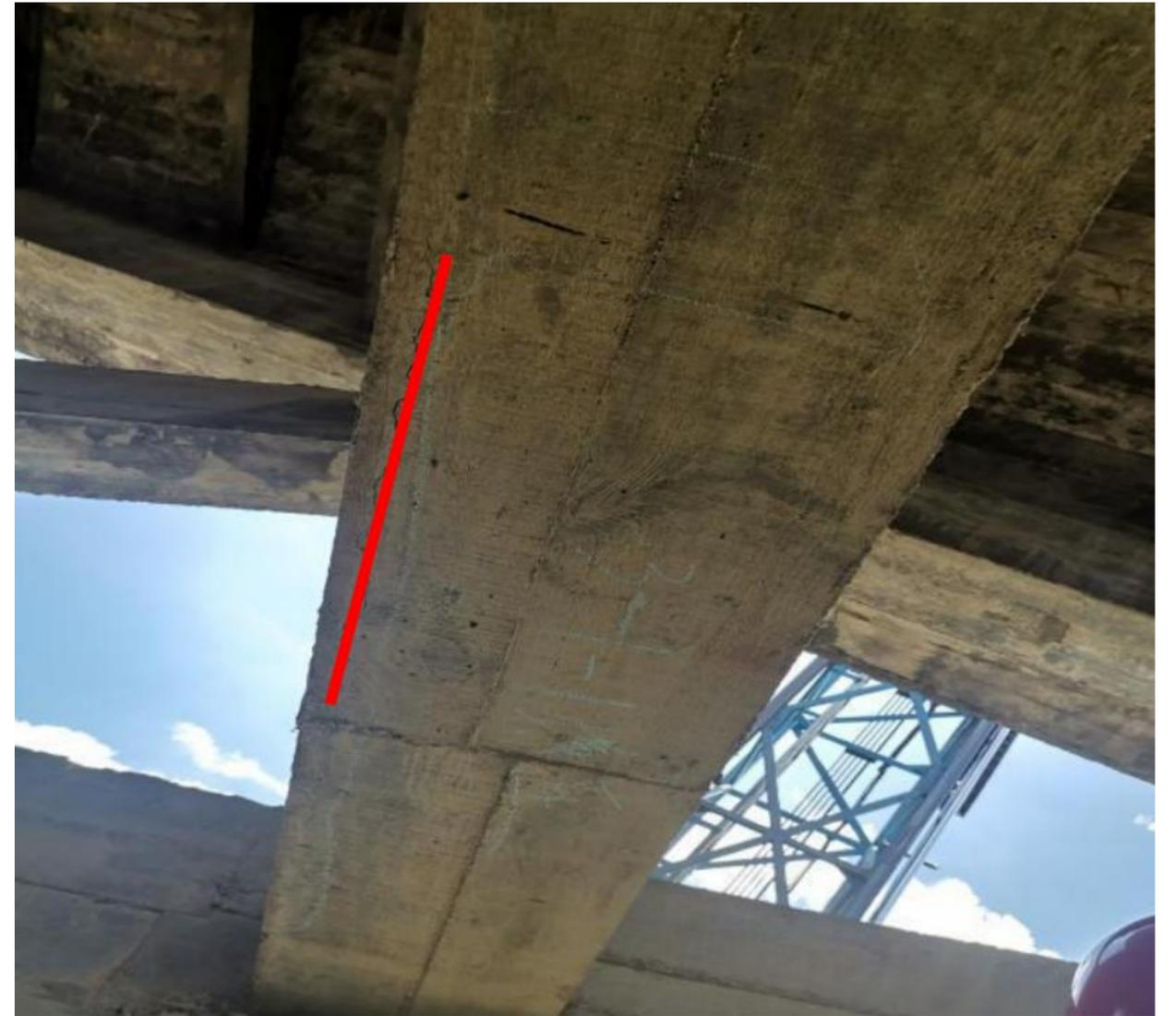
图 3-3 横系梁裂缝
