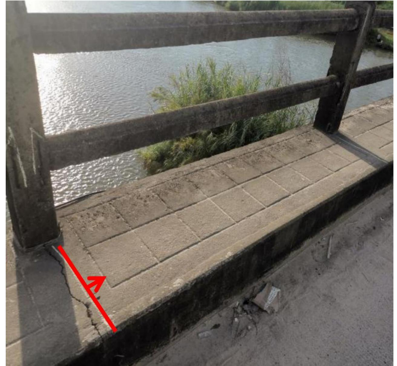
图3-11 人行道裂缝
