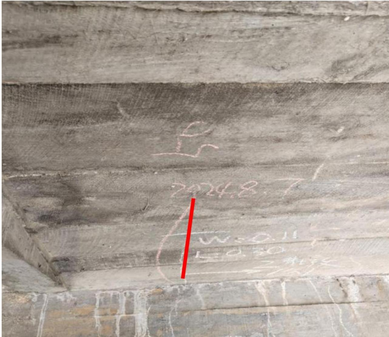
图 3-4 桥面板裂缝
