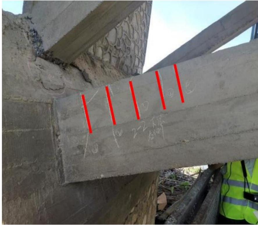
图3-1 拱腿裂缝
