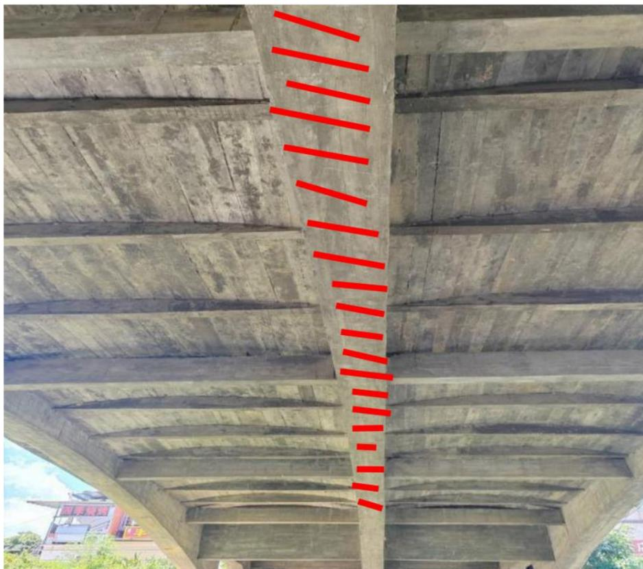
图3-2 拱顶裂缝
