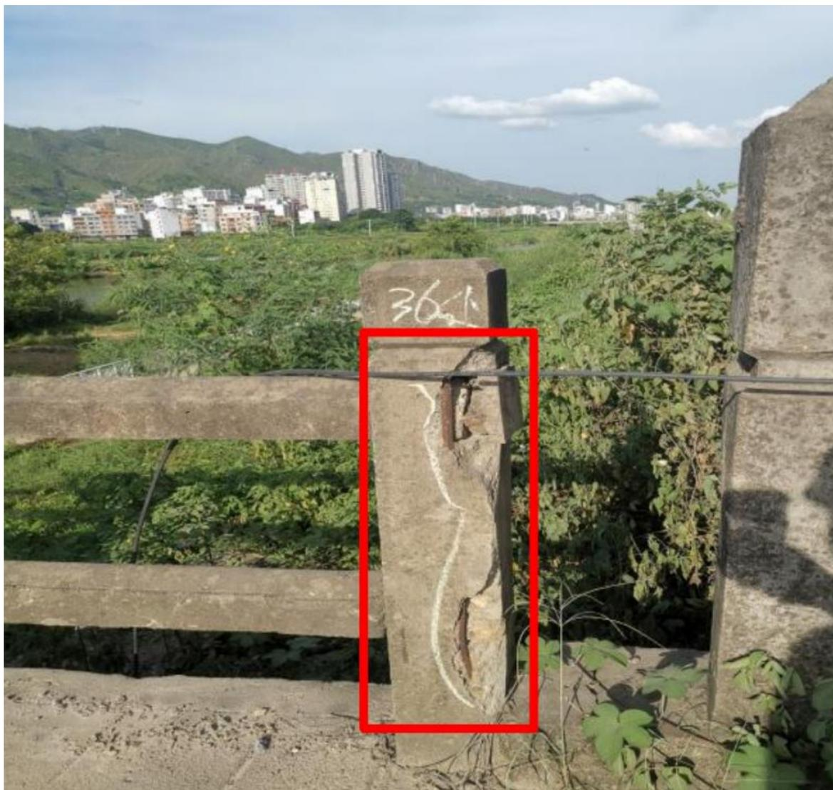
图 3-12 护栏剥落露筋
