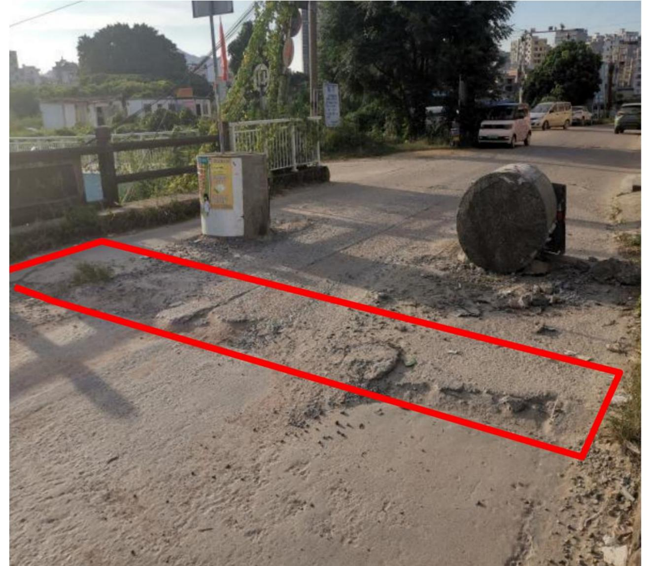
图3-9 桥面破损
