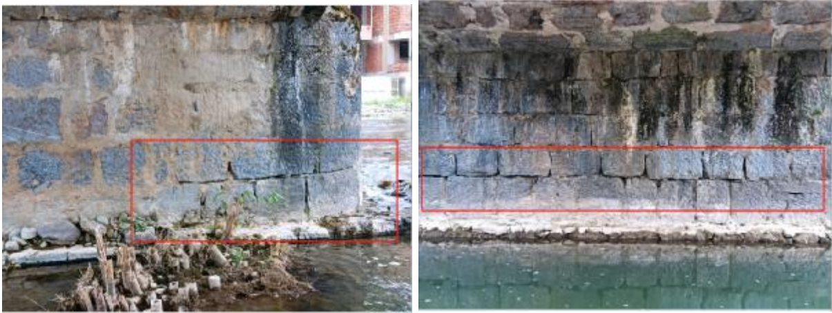
图 4 现状墩、台砂浆脱落照片。
