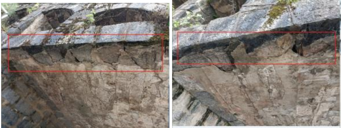
图 2 现状主拱圈灰缝松散脱落照片
