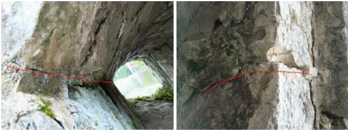
图 3 现状拱上结构砂浆脱落照片
