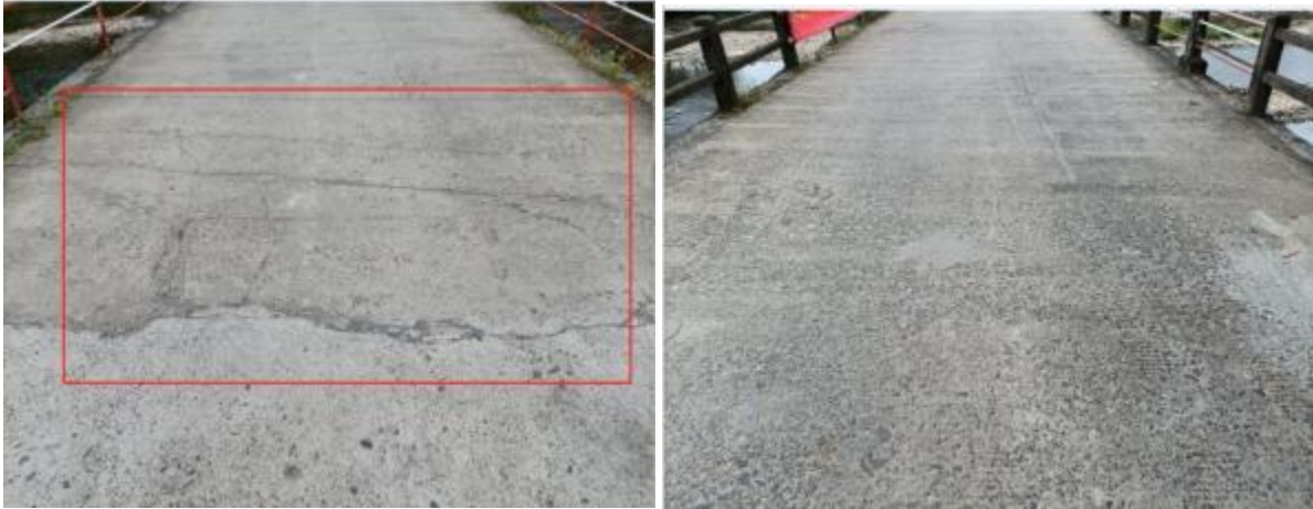
图 5 现状桥面铺装脱皮、露骨；裂缝照片。
