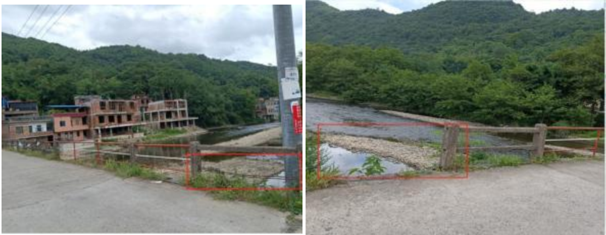
图 6 现状栏杆撞坏、缺失；破损照片。
