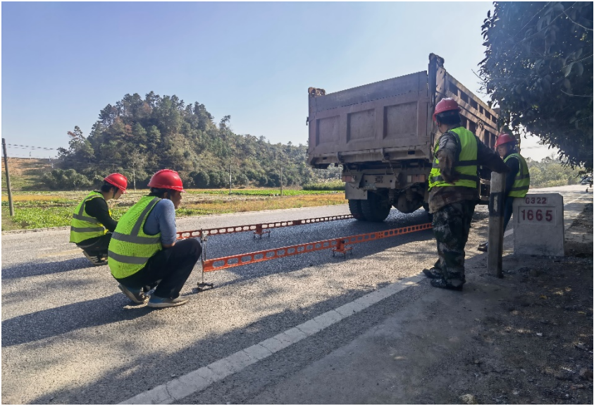
图1.2.3.1-3 旧路路面弯沉检测
