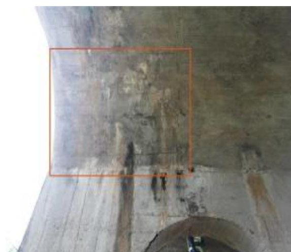
图 2-17 渗水结晶，位于 2#腹拱圈
