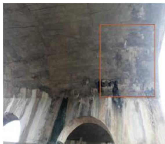
图 2-27 渗水结晶，位于 5#腹拱圈
