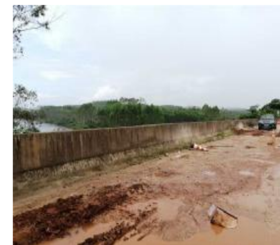
图 2-40 R#护栏无明显病害
