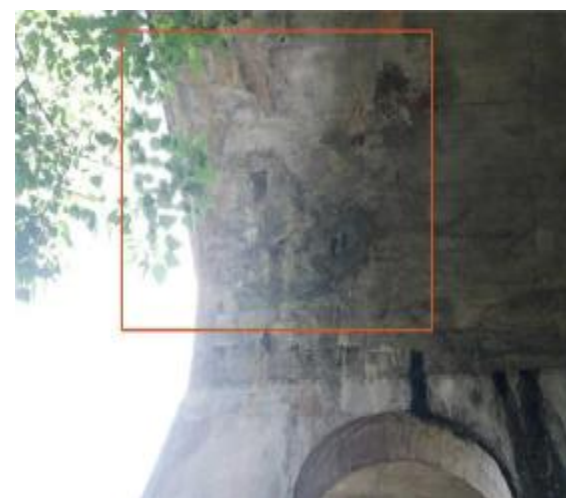
图 2-8 渗水结晶, 位于 1#腹拱圈
