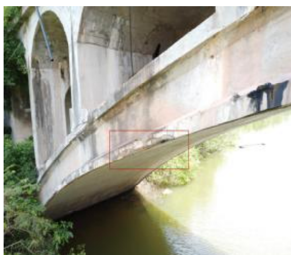
图 2-3 剥落、掉角，位于 1#跨主拱圈
