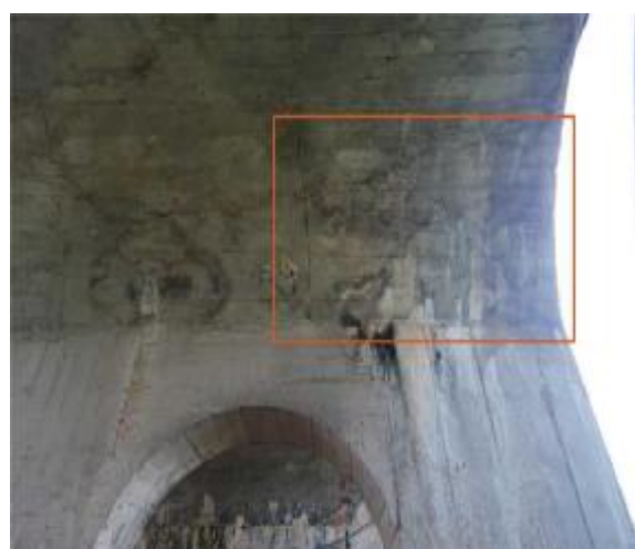
图 2-16 渗水结晶，位于 2#腹拱圈
