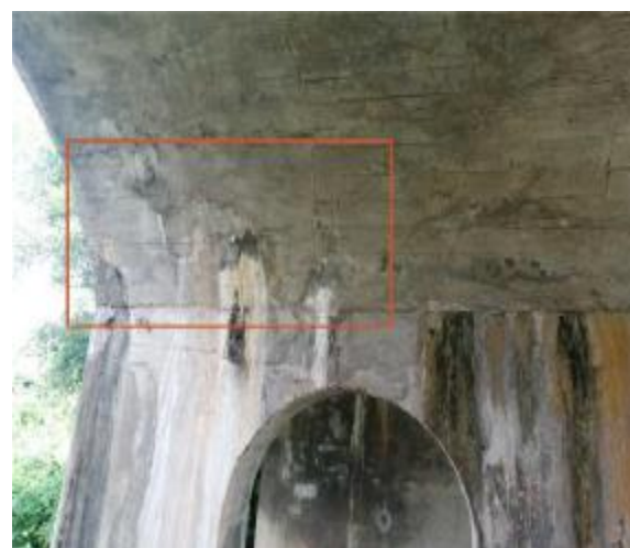
图 2-15 渗水结晶，位于 2#腹拱圈
