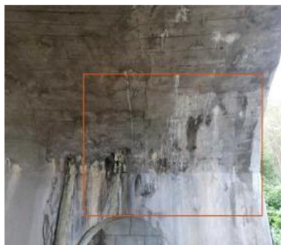
图 2-26 渗水结晶，位于 5#腹拱圈
