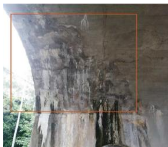
图 2-28 渗水结晶，位于 5#腹拱圈
