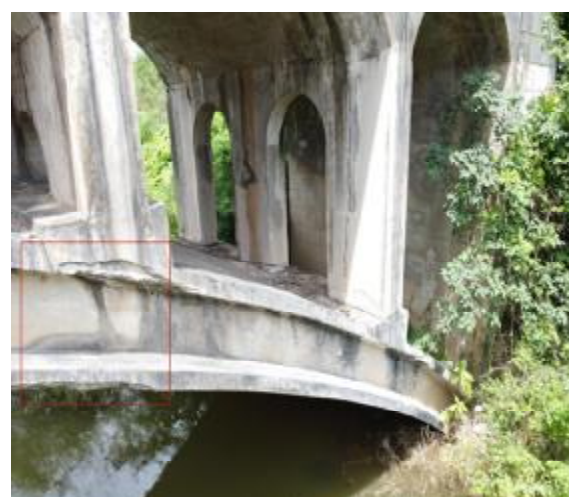
图 2-4 剥落、掉角，位于 1#跨主拱圈
