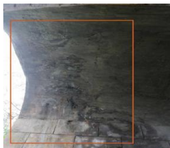
图 2-29 渗水结晶，位于 6#腹拱圈
