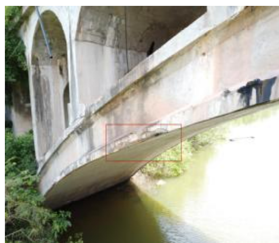
图 2-3 剥落、掉角，位于 1#跨主拱圈
