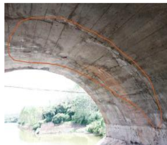
图 2-20 渗水结晶，位于 3#腹拱圈
