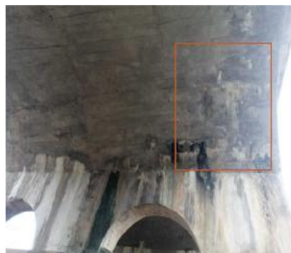
图 2-27 渗水结晶, 位于 5#腹拱圈
