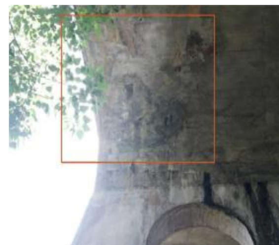
图 2-8 渗水结晶, 位于 1#腹拱圈
