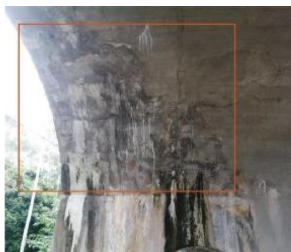
图 2-28 渗水结晶, 位于 5#腹拱圈
