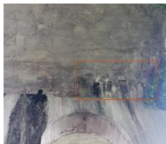
图 2-6 渗水结晶, 位于 1#腹拱圈
