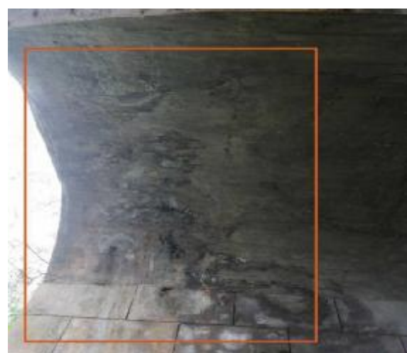
图 2-29 渗水结晶, 位于 6#腹拱圈
