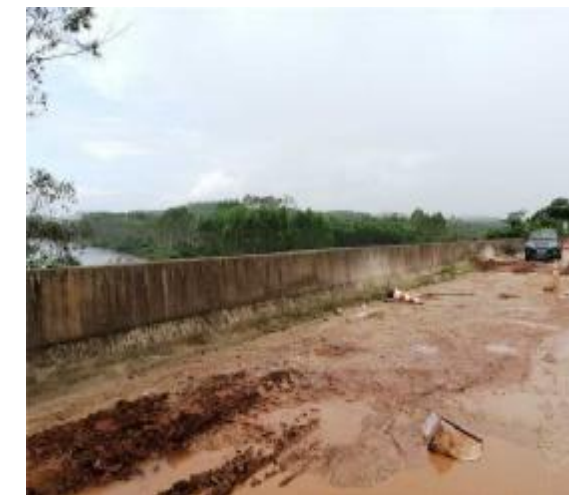
图 2-40 R#护栏无明显病害
