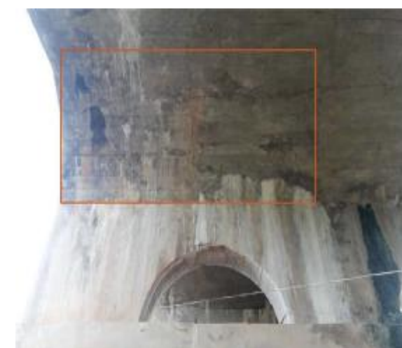
图 2-25 渗水结晶，位于 5#腹拱圈
