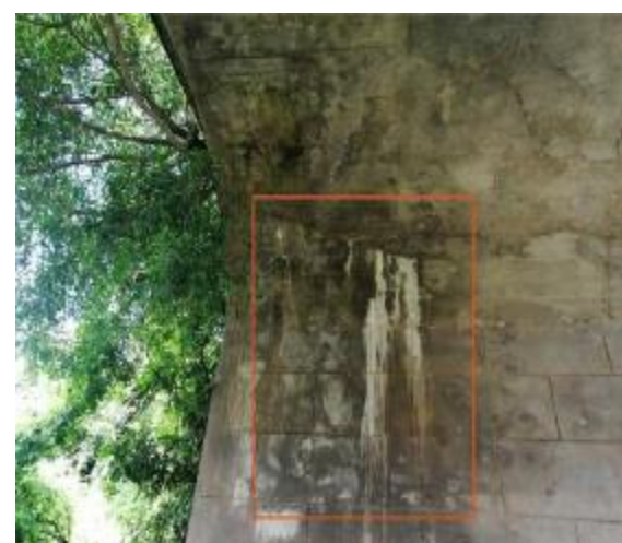
图 2-7 渗水结晶, 位于 1#腹拱圈
