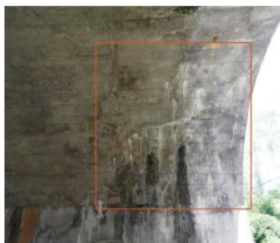
图 2-18 渗水结晶，位于 2#腹拱圈
