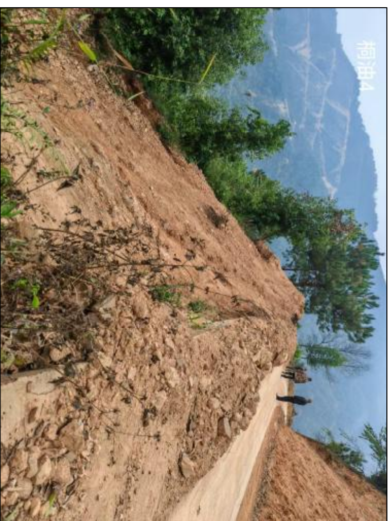
桐油屯生命防护墙4现状图
