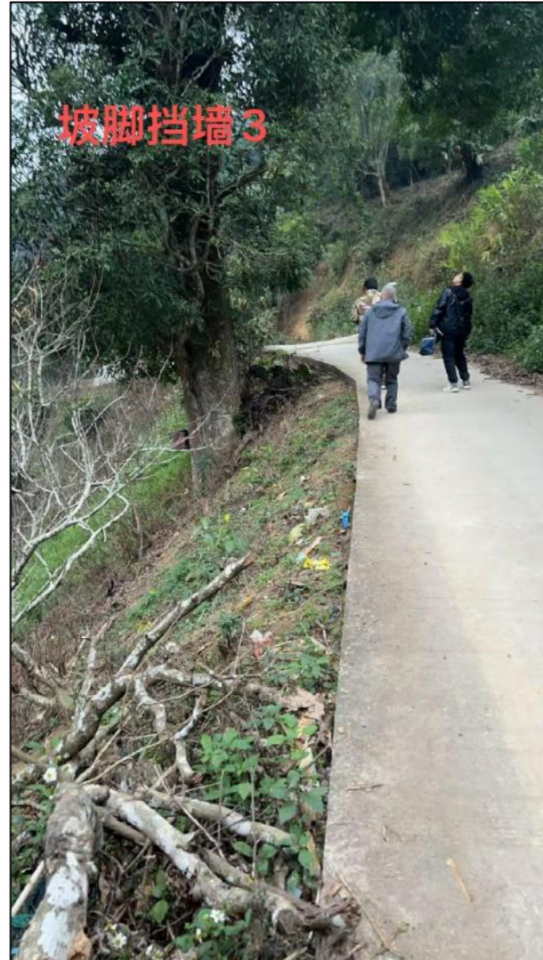
坡脚屯生命防护墙3现状图
