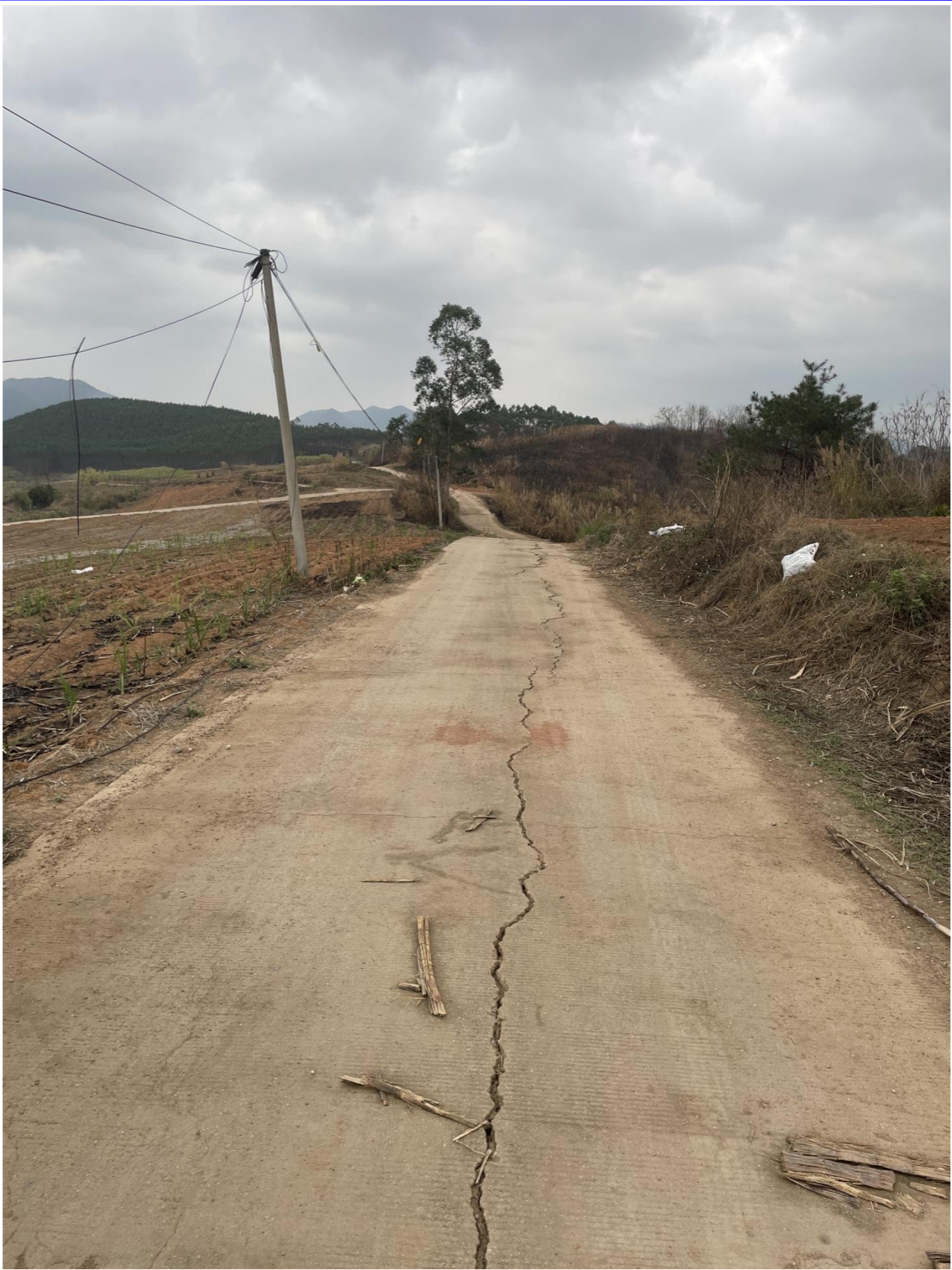
图 3.2-6 现状公路路面裂缝
