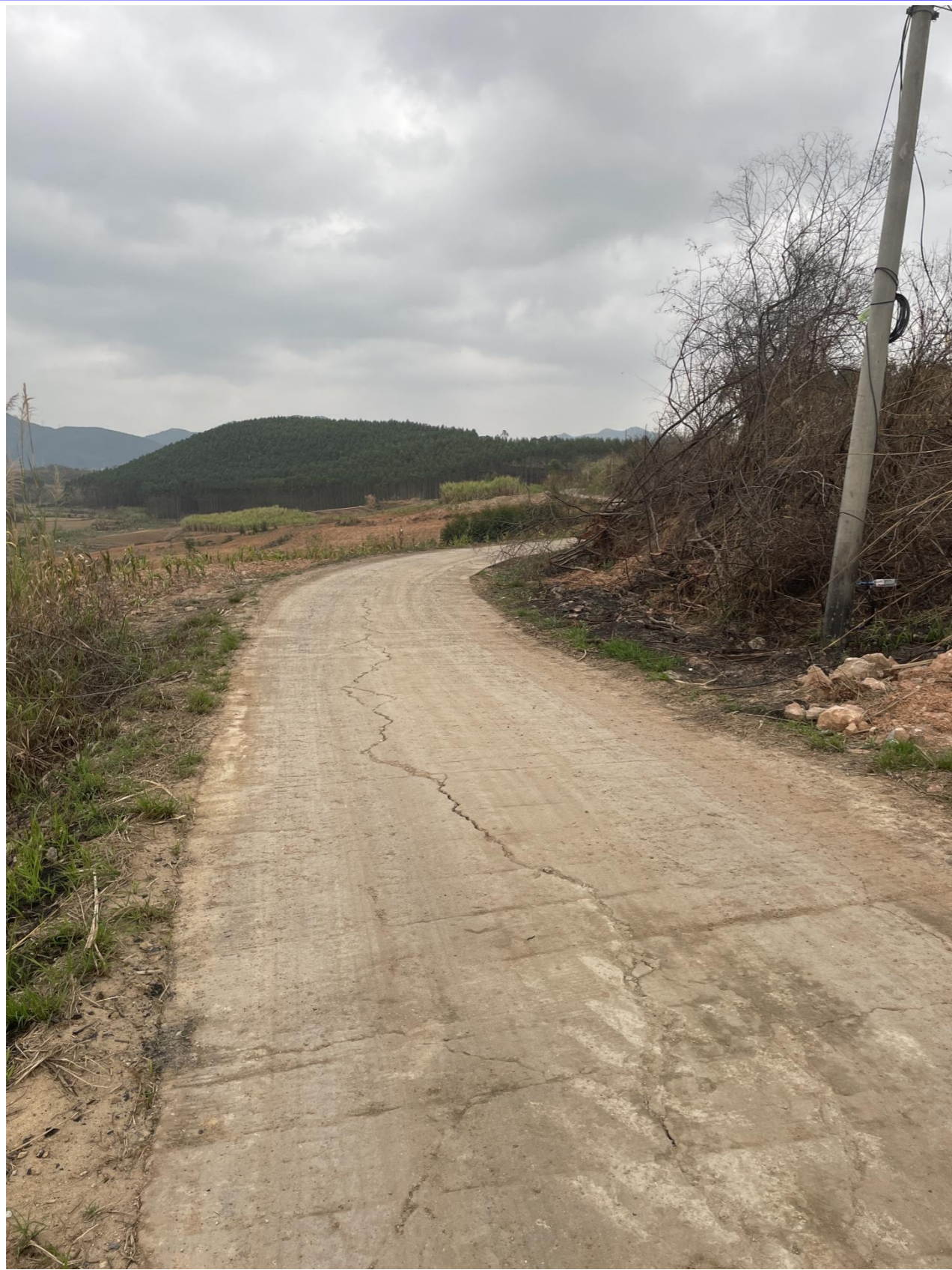
图 3.2-5 现状公路路面裂缝
