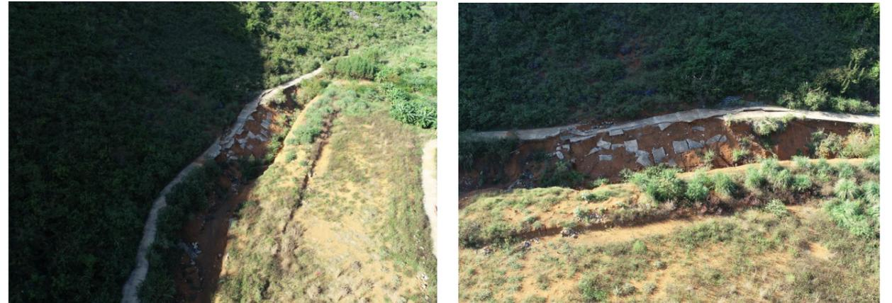
该路段工程量：整修路基：9868 m<sup>2</sup>，挖除旧路面：1117.08m<sup>3</sup>，挖土方：111m<sup>3</sup>，挖石方：4912m<sup>3</sup>，路基填方：2008m<sup>3</sup>，利用土回填：2008m<sup>3</sup>，M7.5浆砌片石挡土墙：567.4m<sup>3</sup>，20cmC30水泥混凝土：8469 m<sup>2</sup>，12cm级配碎石基层：9408 m<sup>2</sup>，1-Φ0.5涵管：23米/3道，单孔钢筋混凝土盖板涵1-2\*2：6米/2道，波形梁钢护栏：994米，单柱式交通标志6块，减速振动标线21.6 m<sup>2</sup>。
