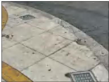
地面铺装现状照片二
