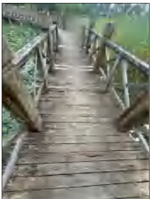
水上栈道现状照片一
