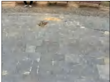
地面铺装现状照片三
