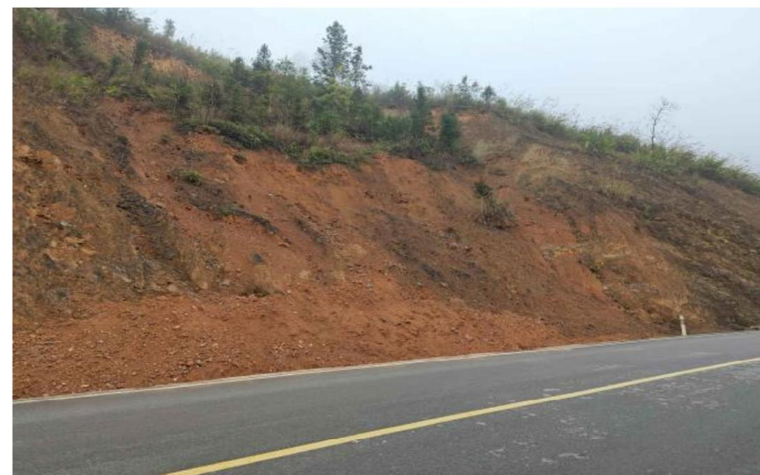
图 1-1-3 G357 线 K2300+340~K2300+360 左侧崩塌
