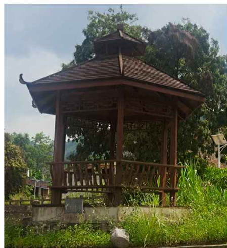
原六角亭翻新换顶板 柱中距3米，高6米
