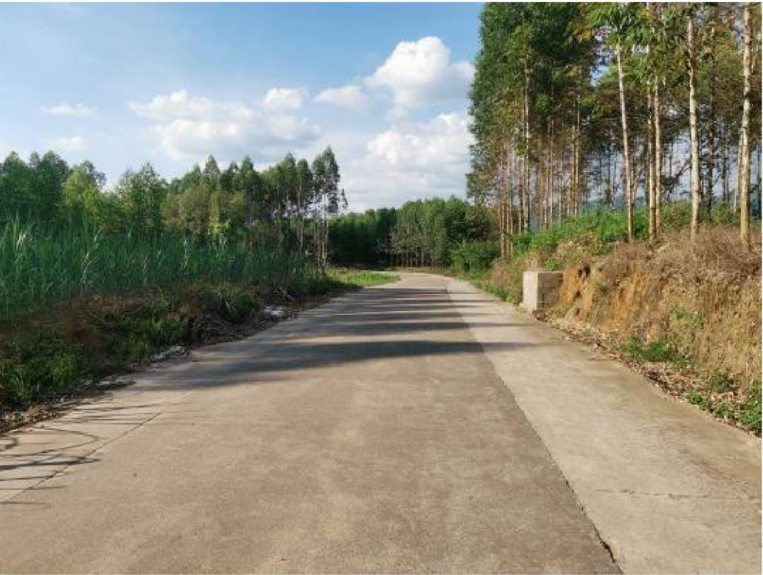
图片1 路线起点附近
