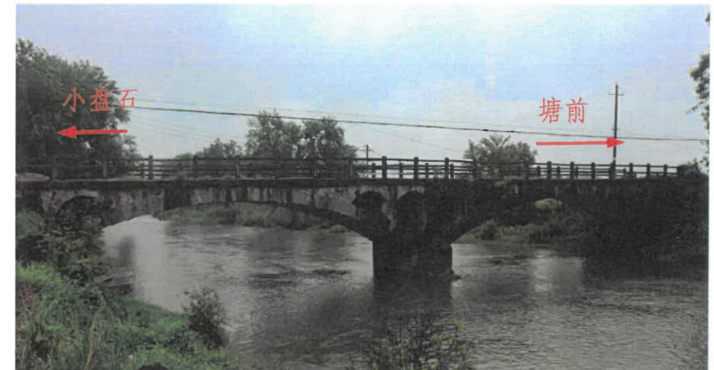
照片 1.1-1 小盘石桥右侧立面照
