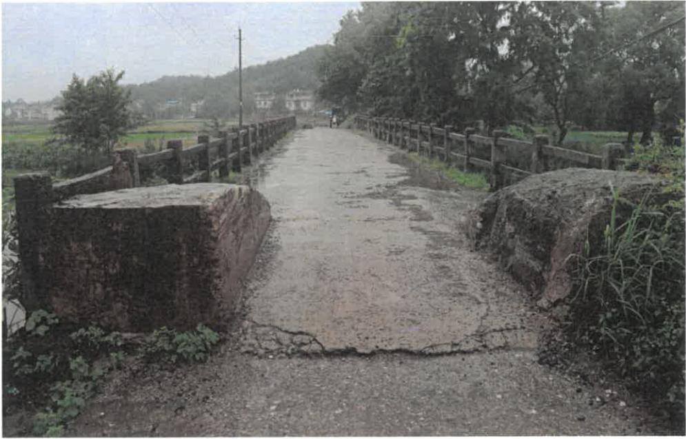
照片 1.1-3 小盘石桥桥头限宽隔离墩
