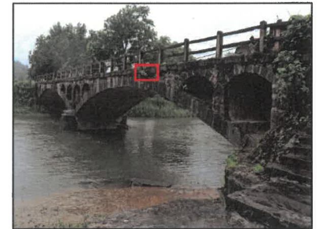
照片 2.1-10 滋生杂草，位于 1#跨拱上侧墙
