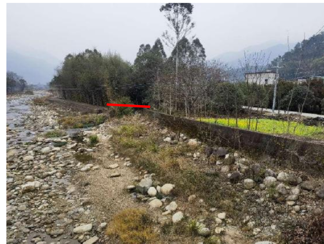
拟建机耕桥位置现状照片
