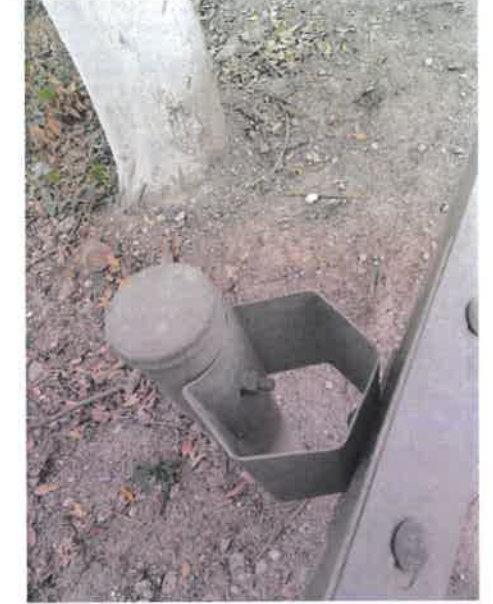
二波护栏板中心距离路面高度约 600mm
