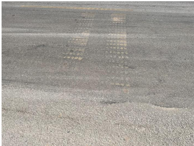
3. 车行道横向减速标线性能效果已不满足现行规范
