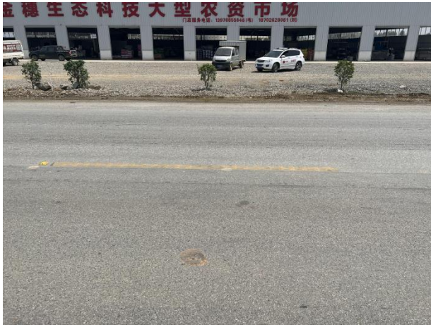
2. 路面标线出现剥落、开裂等不同程度磨损
