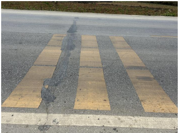
2. 路面标线出现剥落、开裂等不同程度磨损
