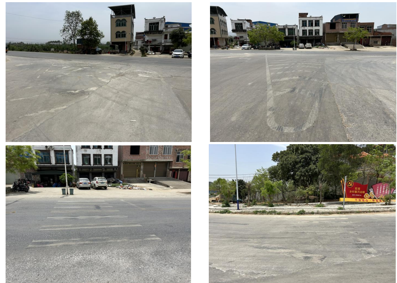
1. 平交道口标线磨损严重
