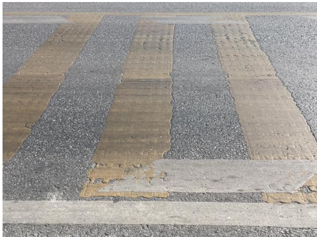
3. 车行道横向减速标线性能效果已不满足现行规范
