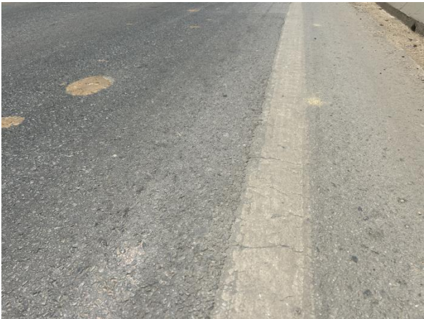
2. 路面标线出现剥落、开裂等不同程度磨损
