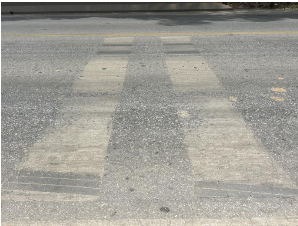
2. 路面标线出现剥落、开裂等不同程度磨损
