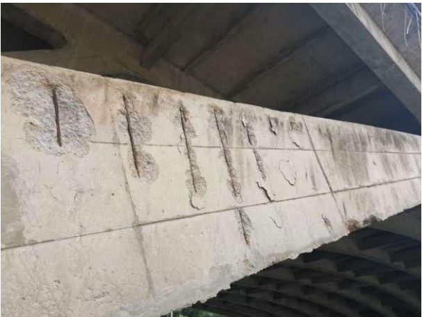
图 2-23 0-10#拱脚剥落露筋
