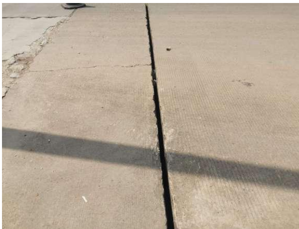
图 2-8 伸缩缝止水带老化破损
