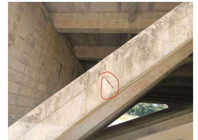
图 2-20 0-10#斜撑剥落露筋
