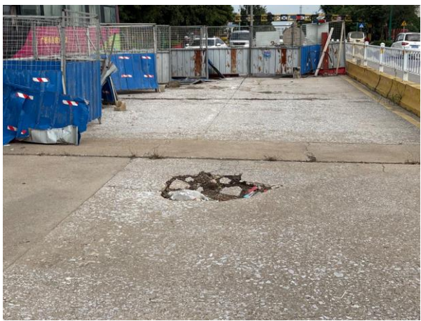
图 2-6 桥面铺装破碎坑槽
