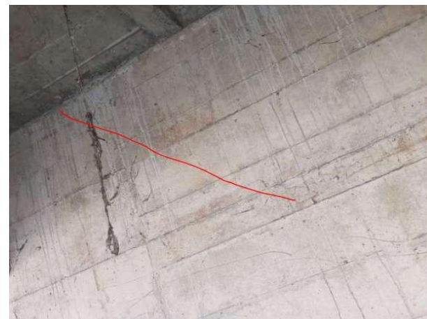
图 2-14 1-5#弦杆斜向裂缝
