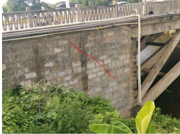
图 2-36 0#桥台斜向裂缝
