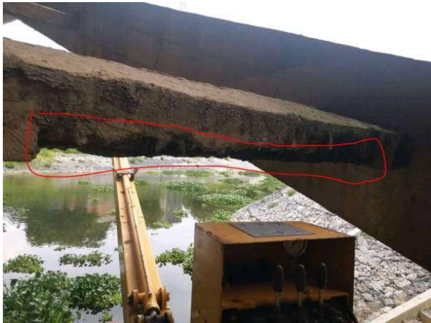
图 2-32 1-16#横系梁剥落露筋
