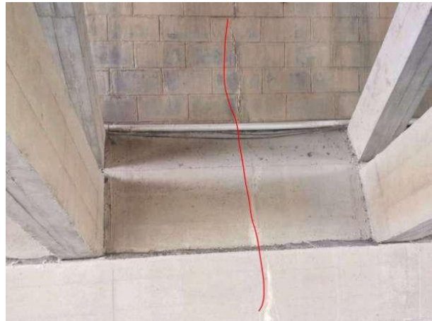
图 2-33 0#桥台竖向裂缝
