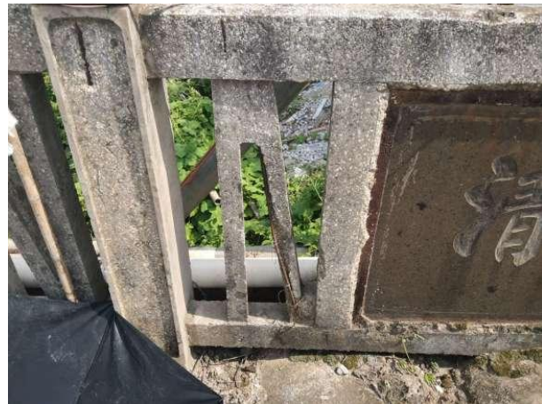
图 2-11 2#栏杆、护栏剥落露筋
