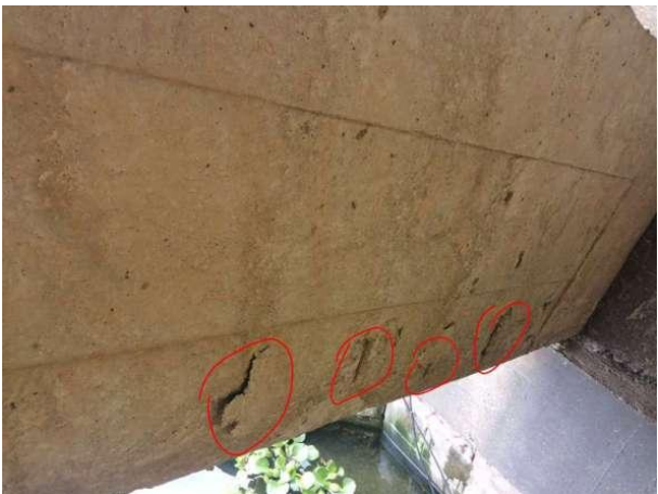
图 2-25 1-10#拱脚剥落露筋
