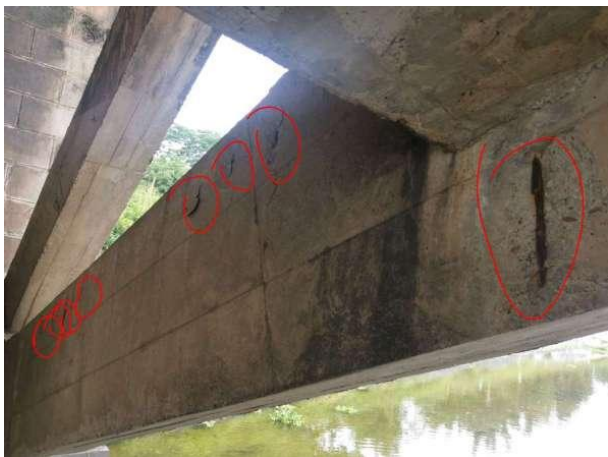
图 2-24 1-10#拱脚剥落露筋
