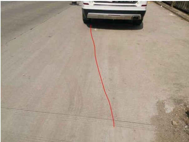
图 2-1 桥面铺装纵向裂缝
