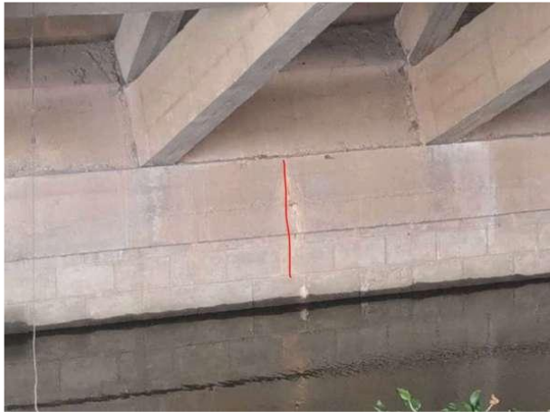
图 2-38 1#桥台竖向裂缝
