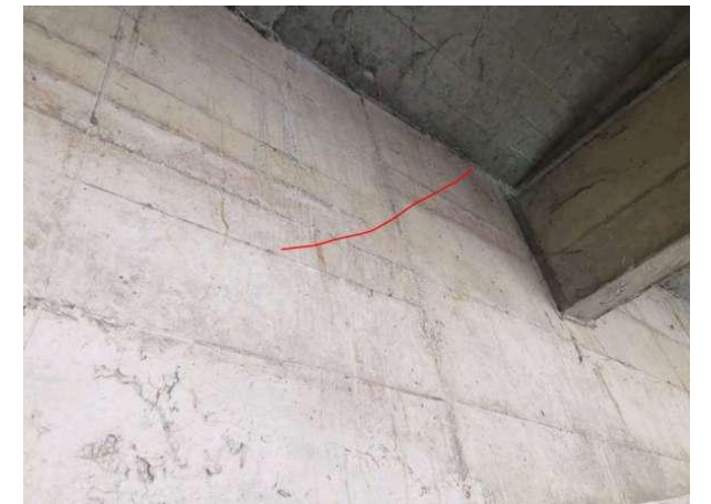
图 2-16 1-5#弦杆斜向裂缝
