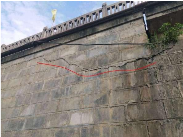
图 2-39 1#桥台纵向裂缝
