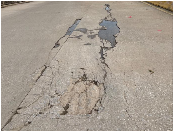
图 2-5 桥面铺装破碎板
