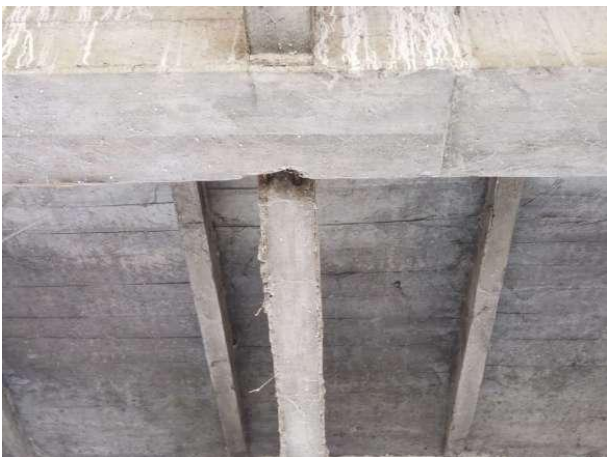
图 2-29 1-9#横系梁剥落露筋
