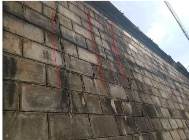
图 2-35 0#桥台竖向裂缝
