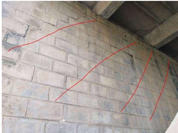
图 2-34 0#桥台斜向裂缝
