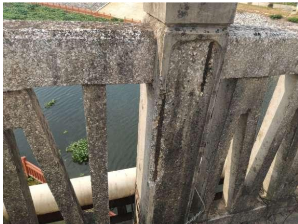
图 2-9 栏杆、护栏剥落露筋
