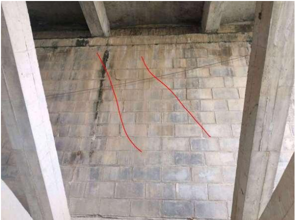
图 2-37 1#桥台斜向裂缝
