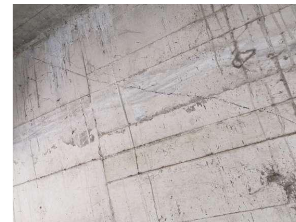
图 2-17 1-6#弦杆斜向裂缝
