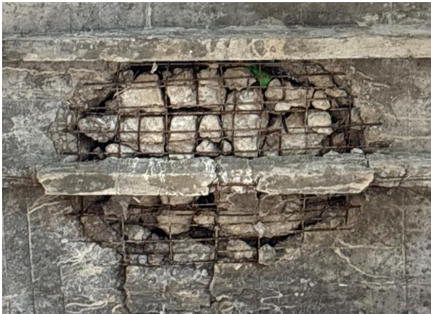
图 2-26 1-4#微弯板破碎凹陷
