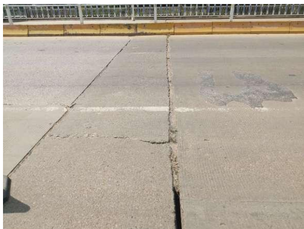
图 2-7 伸缩缝积砂堵塞
