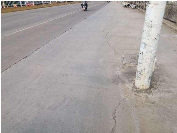
图 2-4 桥面铺装纵向裂缝
