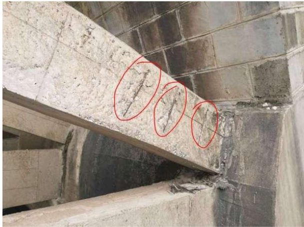
图 2-22 1-10#斜撑剥落露筋
