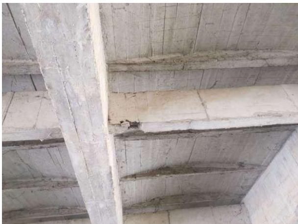
图 2-30 1-10#横系梁剥落露筋
