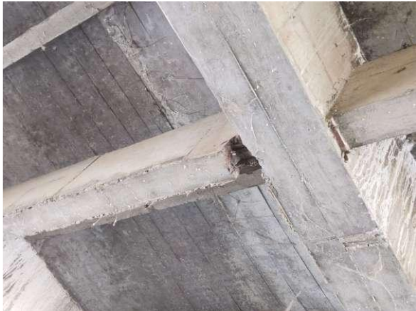
图 2-28 1-8#横系梁剥落露筋
