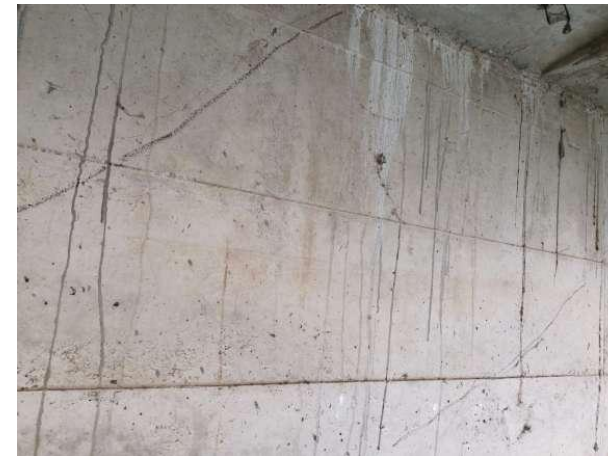
图 2-15 1-5#弦杆斜向裂缝
