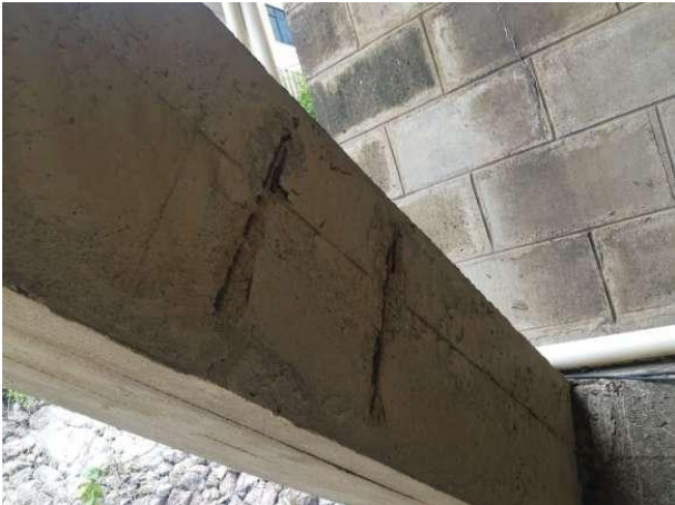
图 2-21 0-10#斜撑剥落露筋
