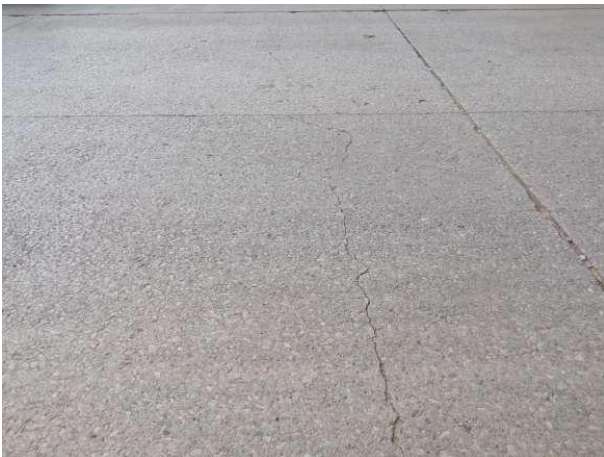
图 2-3 桥面铺装横向裂缝
