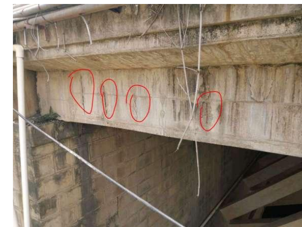
图 2-19 1-10#弦杆剥落露筋
