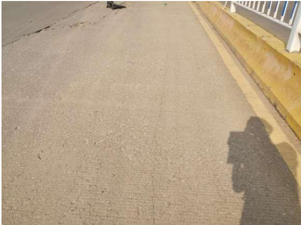
图 2-2 桥面铺装纵向裂缝
