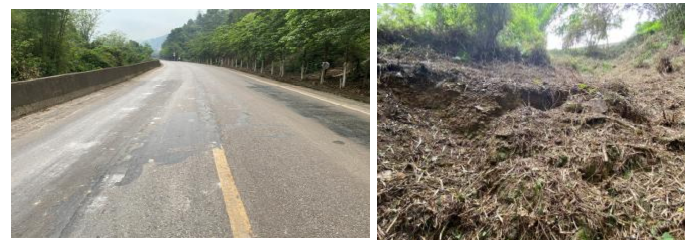
图 4-1 K3087+826-K3087+933 段路堤现场照片（2024 年 5 月摄）
