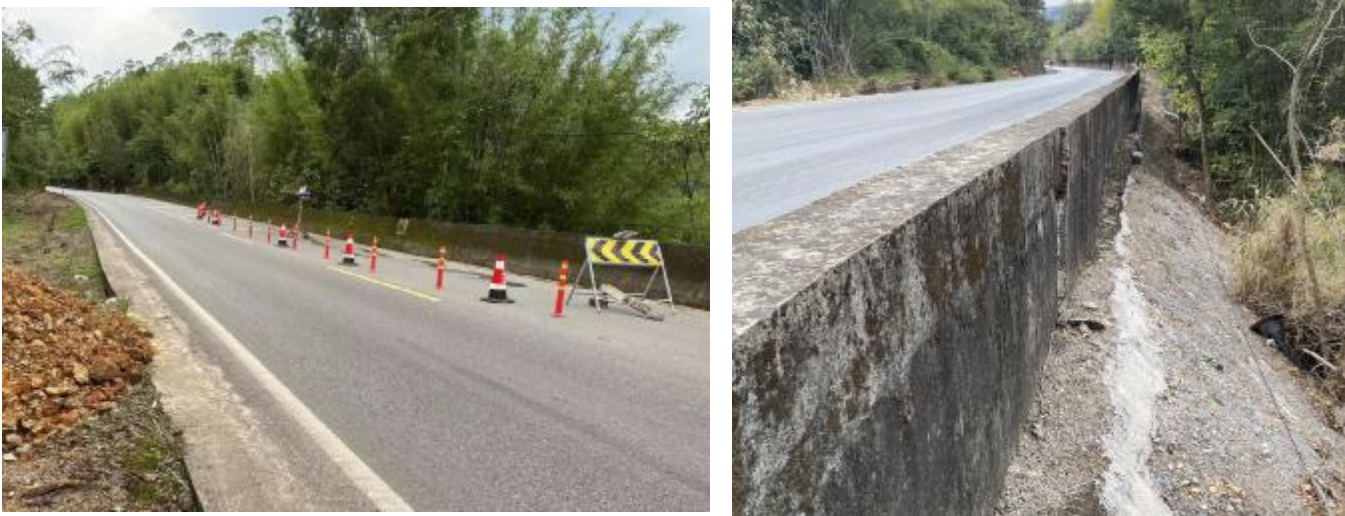
图 4-2 K3088+050-K3088+150 段路堤现场照片（2024 年 5 月摄）
