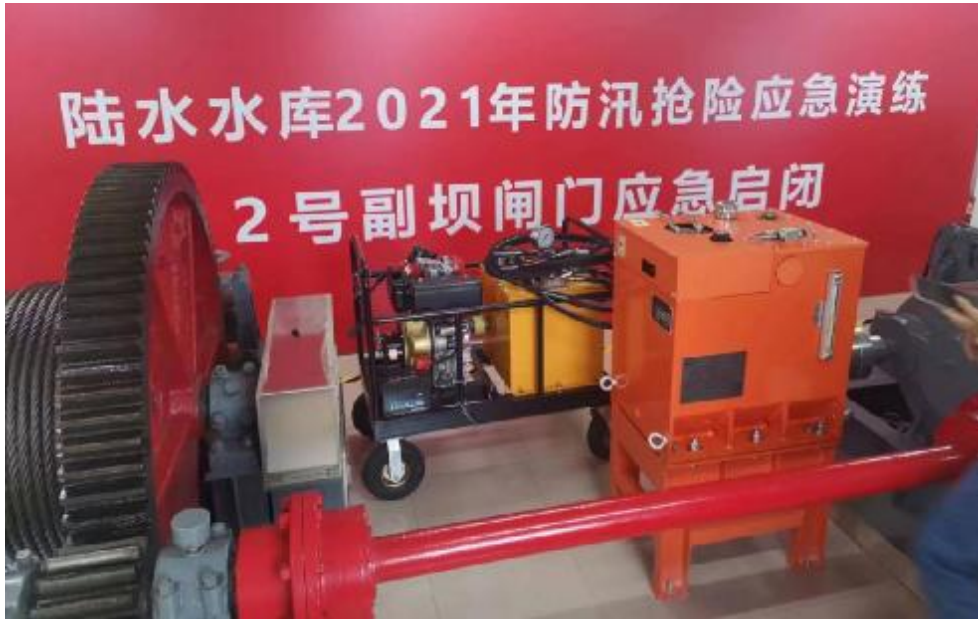
图 4-11-1 启闭机应急启动装置
