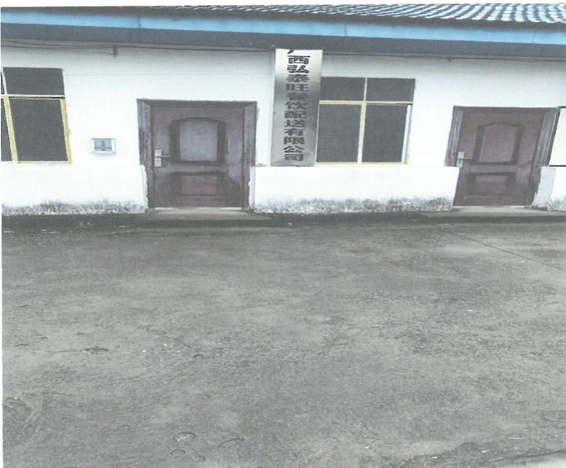
广西弘泰旺餐饮配送有限公司实地图片
