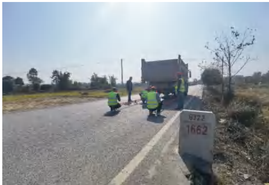
图1.2.3.1-3 旧路路面弯沉检测
