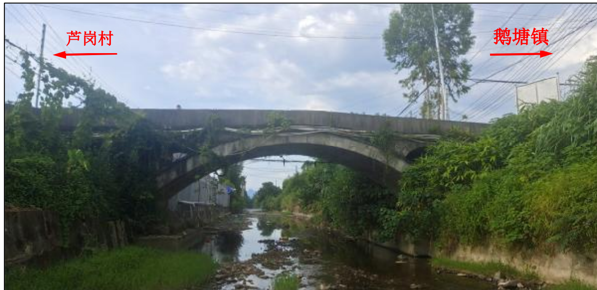
照片 1-1 芦岗桥立面照
