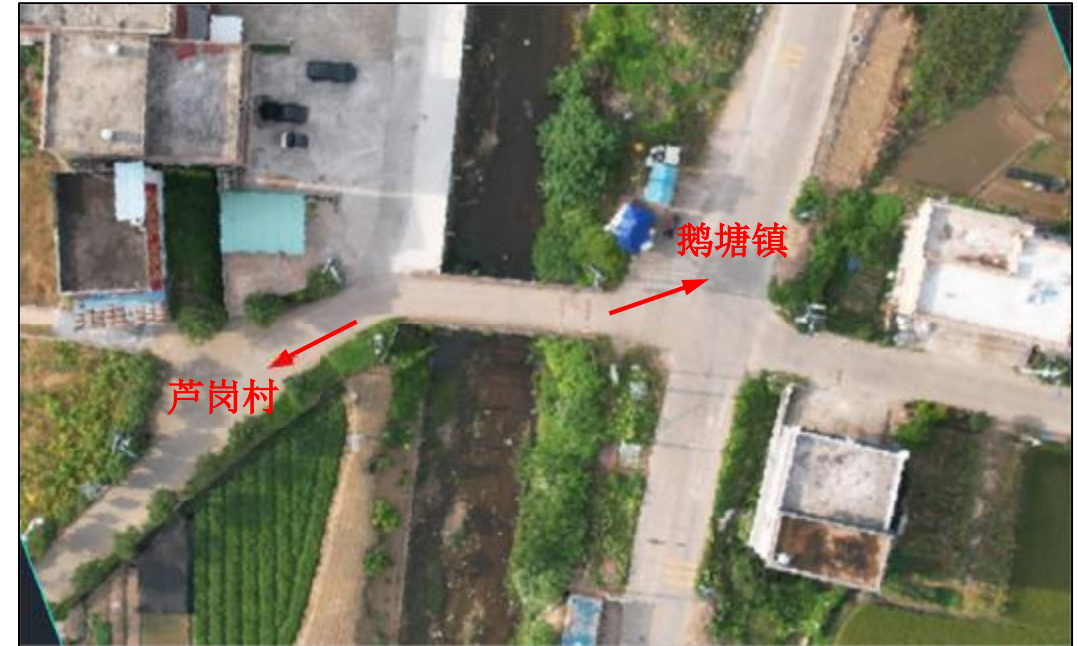
照片 1-2 芦岗桥桥位照
