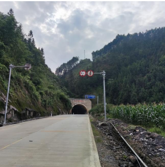
林佑坳隧道出口
