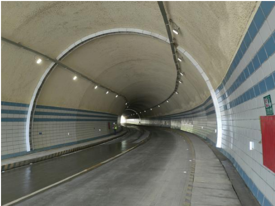
吊顶及各种预埋件现状
