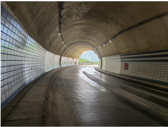
排水系统现状
