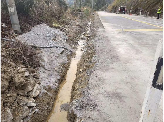
隧道出口边沟现状
