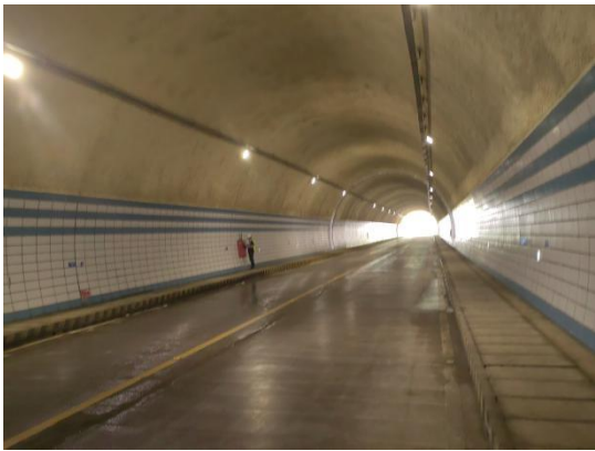
排水系统现状
