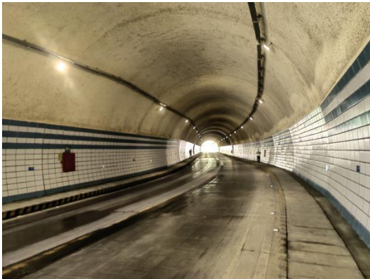
吊顶及各种预埋件现状
